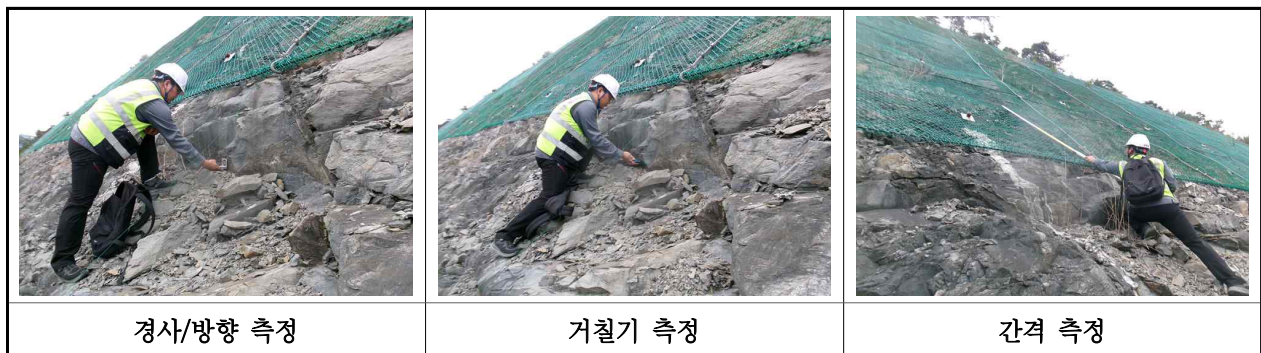
【사진 47.3.3】 불연속면 측정 현황
